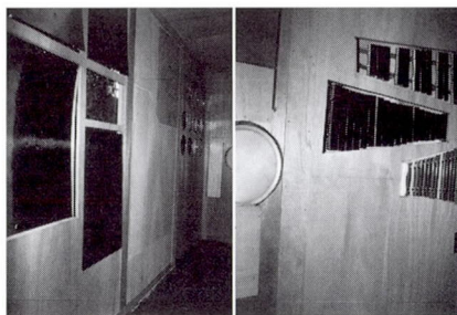
音壁の仕掛け。音の部屋は金属板や木琴、鉄琴、太鼓などを仕込み、黒い布をかけて仕掛けを見えなくしたものです。
